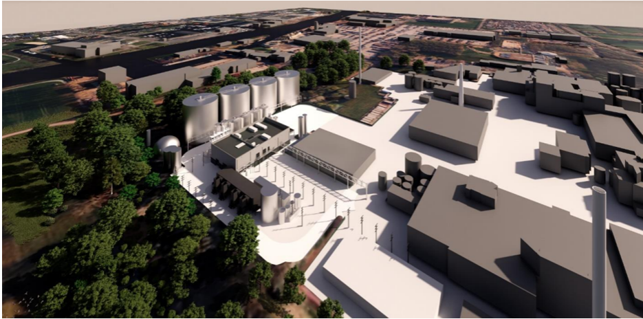
Afbeelding: Aan de linkerkzijde de groengasinstallatie met de 3 hoofdvergisters en de navergister. Afbeelding komt uit de ruimtelijke onderbouwing (onderdeel van bijlage 2).
