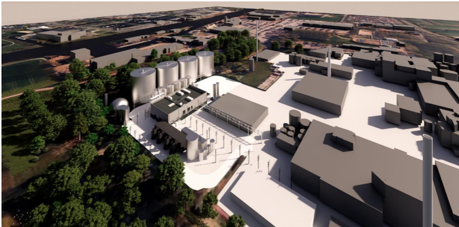
Afbeelding: Aan de linkerzijde de groengasinstallatie met de 3 hoofdvergisters en de navergister. Afbeelding komt uit de ruimtelijke onderbouwing (onderdeel van bijlage 2).
